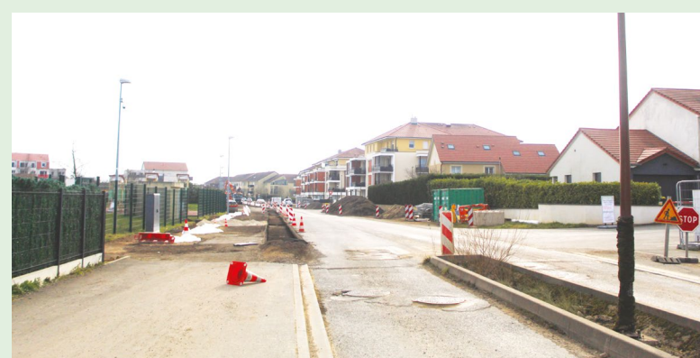
La rue Pierre Messmer fait l'objet de travaux de réaménagement permettant de sécuriser et d'améliorer le cadre de vie des habitants. Ces travaux seront achevés en juin.
