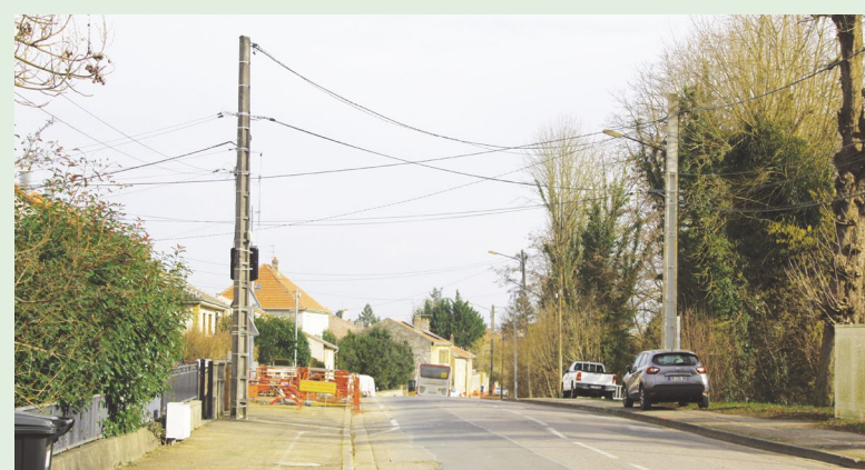
Rue métropolitaine, la rue de Briey fait l'objet de gros travaux de requalification.
